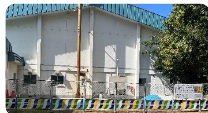
9月：避難所用発電機設置に係る工事開始（体育館東側）
